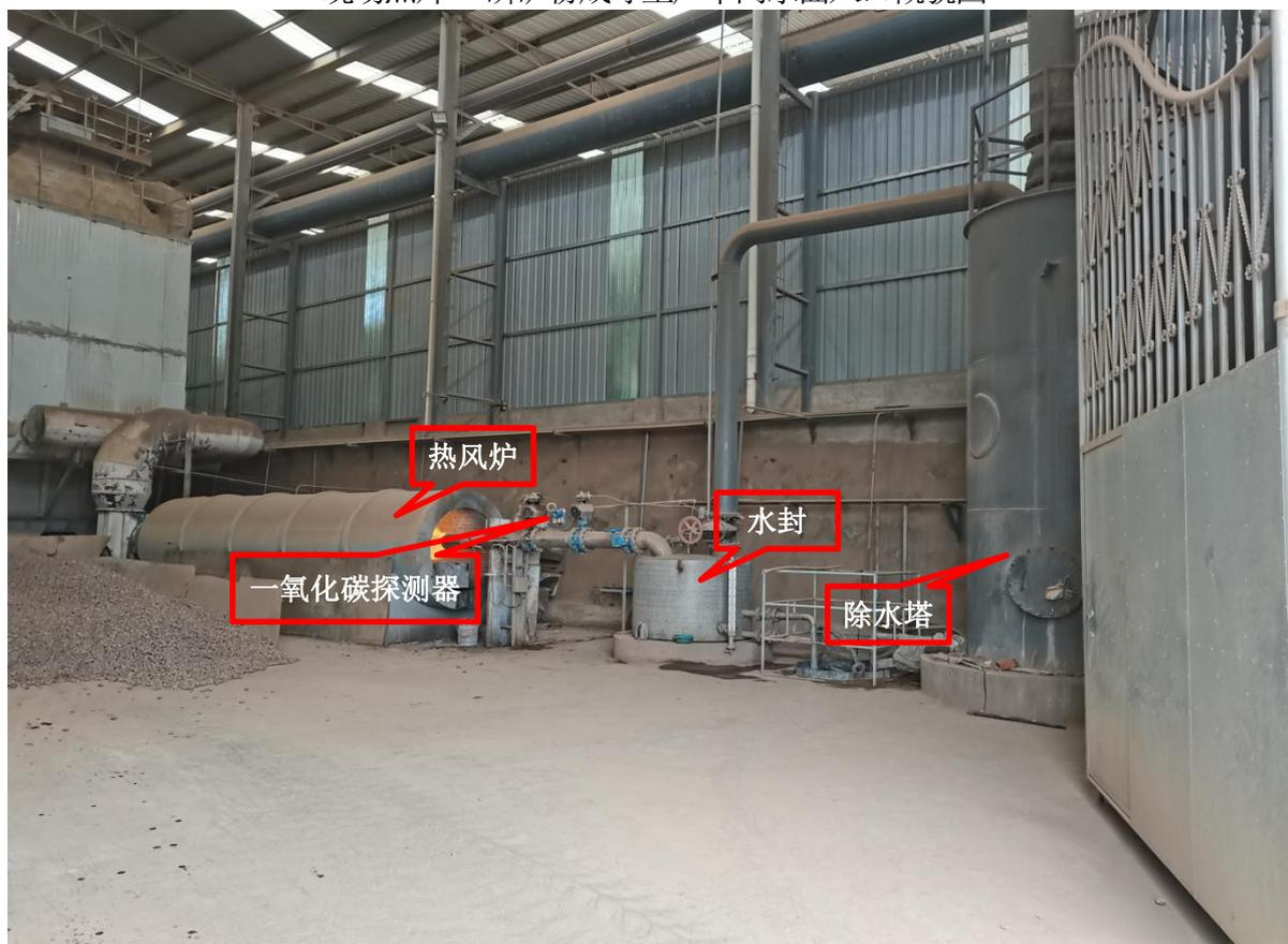
现场照片3 水封及热风炉
