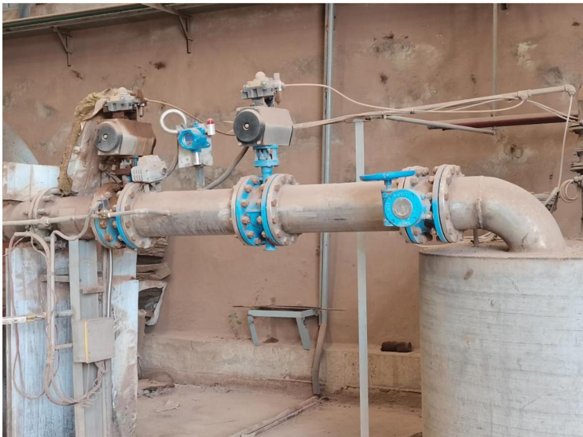
现场照片4 尾气管道紧急自动切断阀
